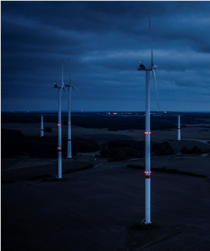
Künftig werden die Signalleuchten an den Windenergieanlagen nur noch aktiviert, wenn ein Flugobjekt in der Nähe ist. Foto: Jörg Weusthoff
