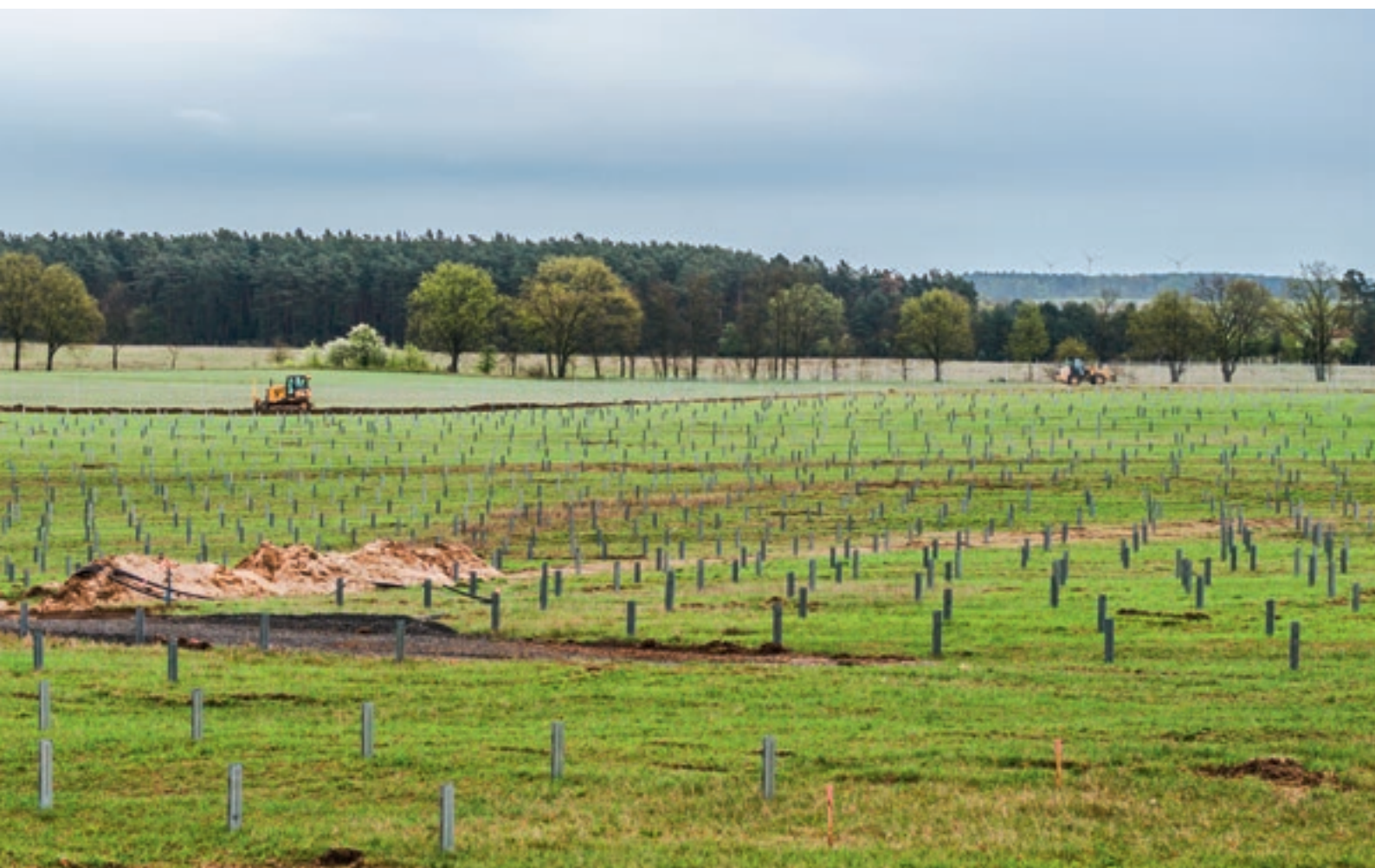
Die Arbeiten am Solarpark Georgenthal/Falkenhagen haben begonnen: Zäune ziehen, Leitungen legen – im Herbst soll die Stromlieferung beginnen.
