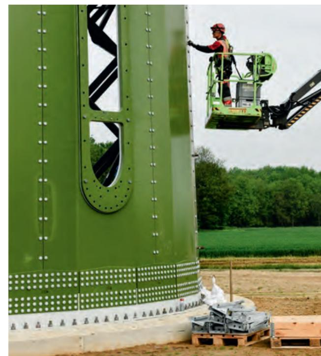
Bauphasen: Die Turmteile werden zusammengesetzt (links), Anbau des dritten Rotorblattes, letzte Inspektion der Gondel und Kontrolle am Turmeinstieg (Abb. von oben nach unten).
