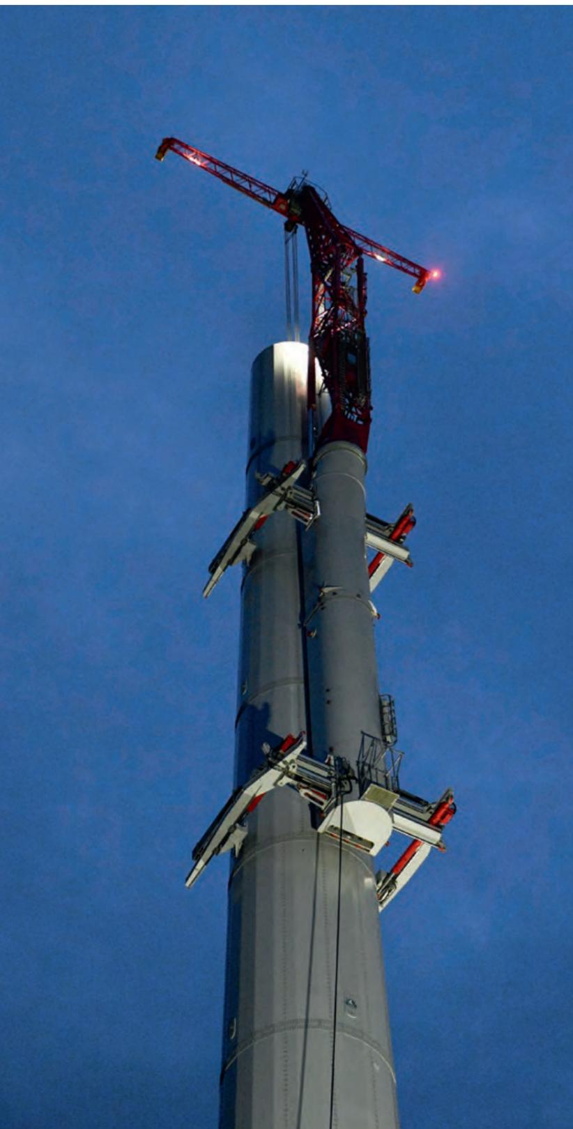
Der Kletterkran baut Stück für Stück den Turm in die Höhe. Die einzelnen Segmente, hier gut erkennbar, sind deutlich kleiner als bei konventionellen Turmbauten.
