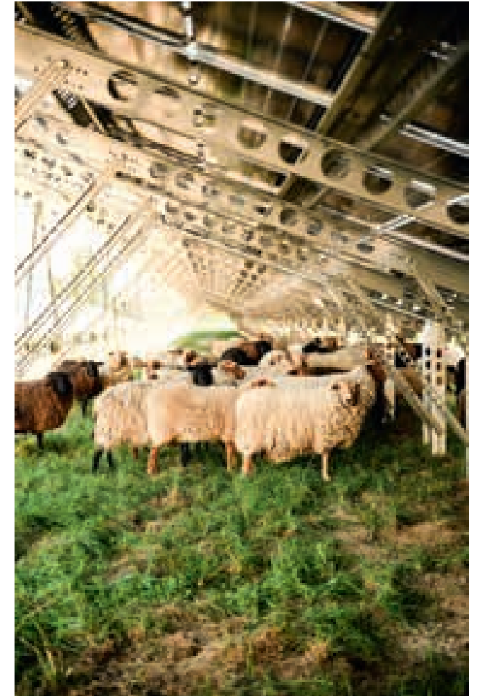
Unter Solarmodulen wächst es weiter – zur Freude der Schafe.
