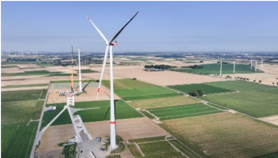
Beide 250 Meter hohen Windenergieanlagen im Windpark Erkelenz-Holzweiler sind vollständig errichtet.
